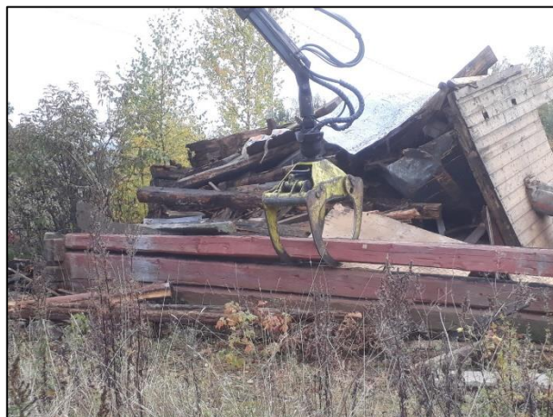
Kuva 1 Riihen purku tukkinosturilla
